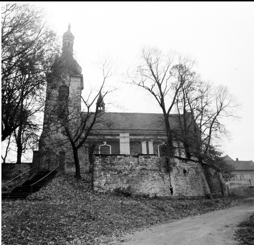
Celkový pohled od severu. Foto: 1975, sbírka negativů NPÚ ÚOP v Ústí n. L., sign. 54477.
