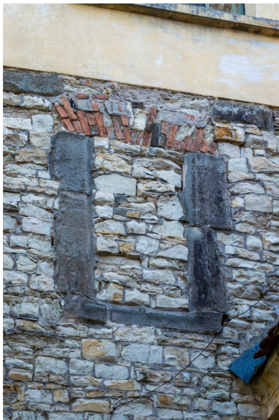
Detail bývalého středověkého zvonového okna na západním průčelí věže. Foto: Marta Pavlíková 2019.
