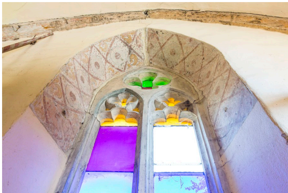
Východní okenní otvor presbytáře v pohledu od západu. Foto: Marta Pavlíková 2019.
