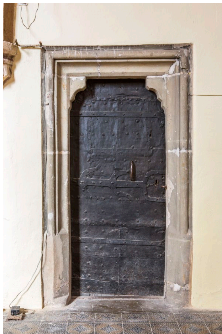
Čelní pohled od jihu z presbytáře na portál zpřístupňující sakristii. Foto: Marta Pavlíková 2019.
