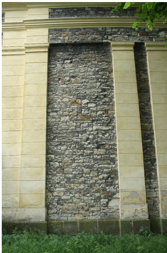
Detail zdiva v ose severního průčelí lodi se zřetelnou vertikální spárou mezi pilastry. Foto: Jaroslav Skopec 2011.
