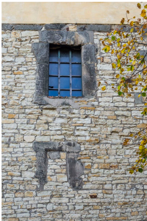
Detail zazděných severních okenních otvorů 1. a 2. patra věže. Foto: Marta Pavlíková 2019.
