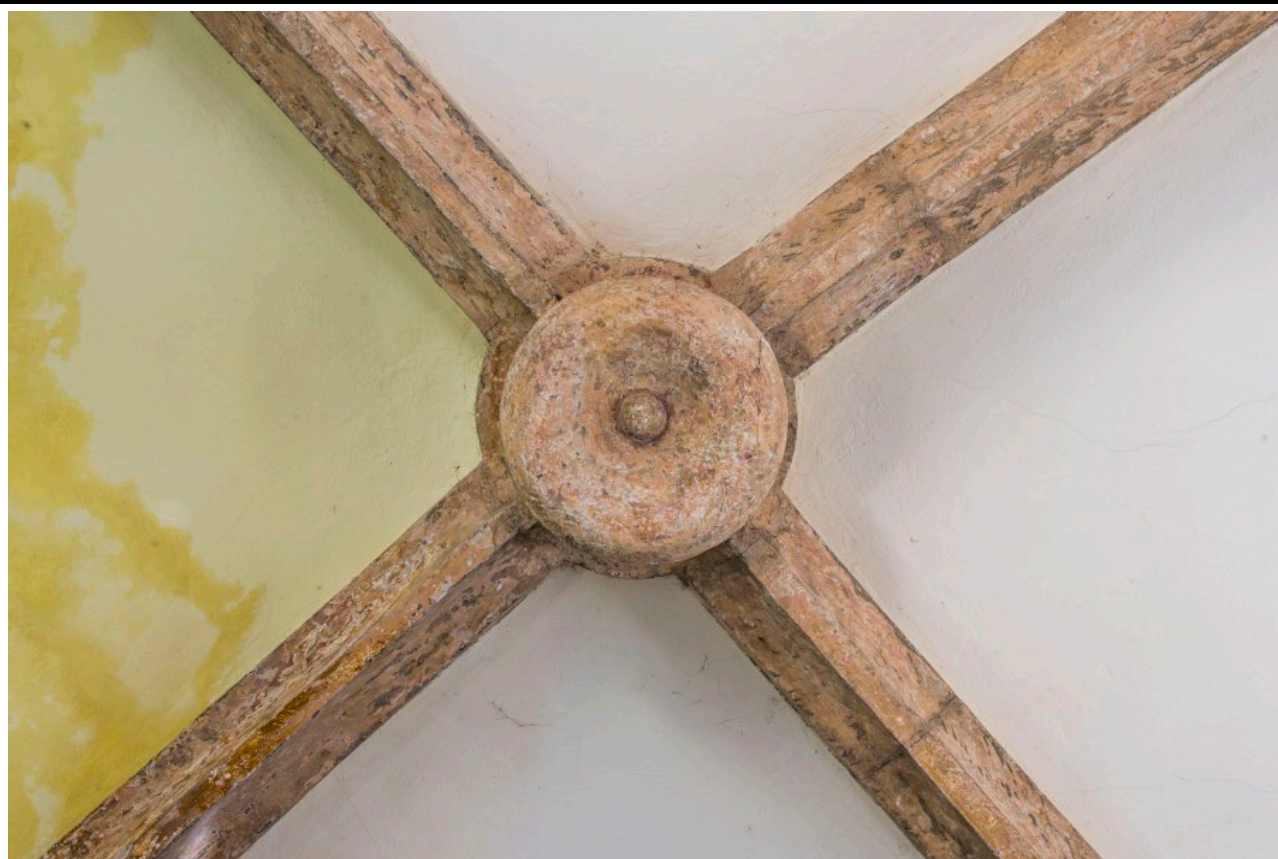
Detail svorníku klenby presbytáře v pohledu. Foto: Marta Pavlíková 2019.
