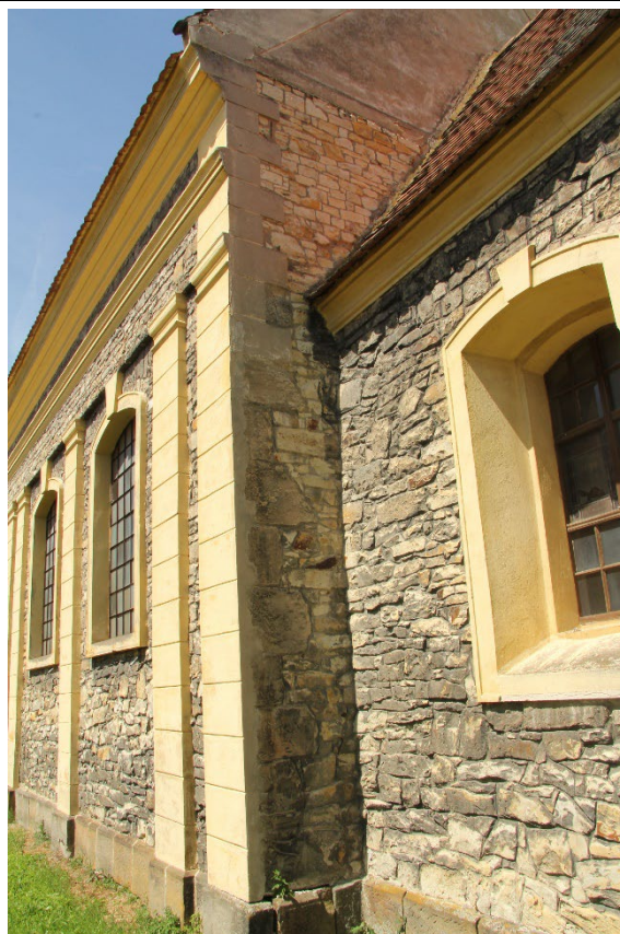
Detail armování jihovýchodního nároží lodi v pohledu od jihovýchodu. Foto: Jaroslav Skopec 2019.
