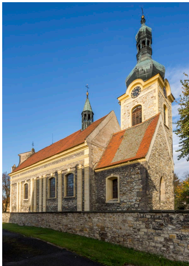
Celkový pohled od jihovýchodu. Foto: Marta Pavlíková 2019.
