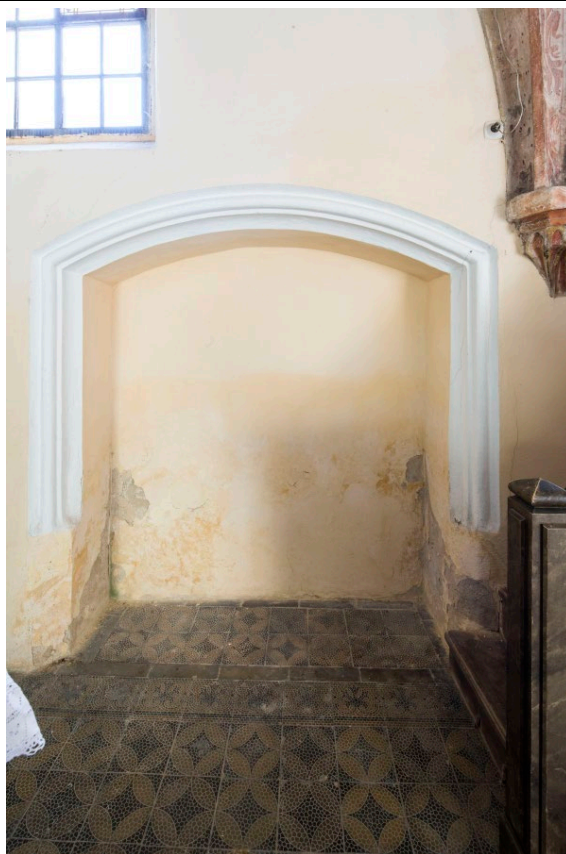
Nika v jižní stěně presbytáře v pohledu od severu. Foto: Marta Pavlíková 2019.
